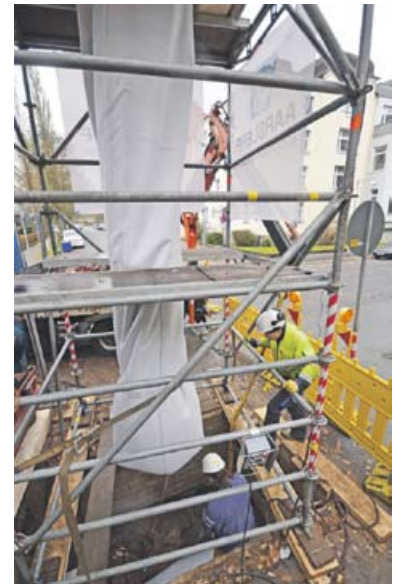
Der umgekrempelte Liner in der Baugrube, bevor er in den Sammler eingeführt wurde.
