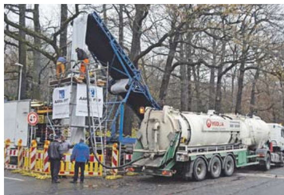
Tankwagen stellten das Wasser für den Inversions- und Aushärtungs-Prozess bereit.
