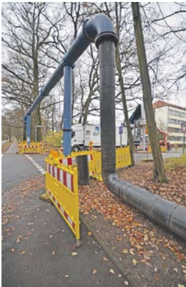
Eine leistungsstarke Wasserhaltung mit mächtigen Rohrbrücken leitete das Abwasser des Sammlers während der Liner-Installation an der Baustelle vorbei.
