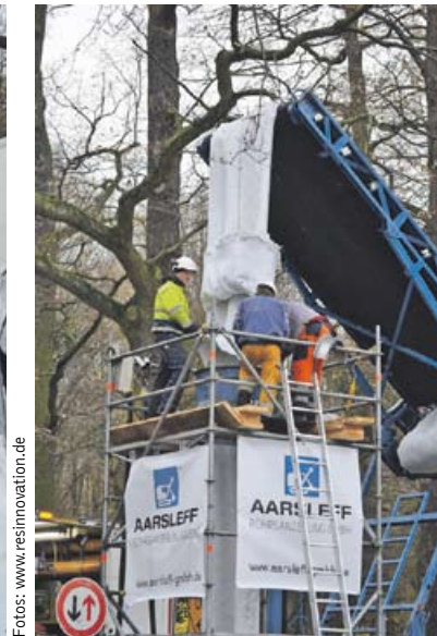
Der Liner wird anschließend am Inversionsrohr angeflanscht, um ihn mit Wasserdruck invertieren zu können.
